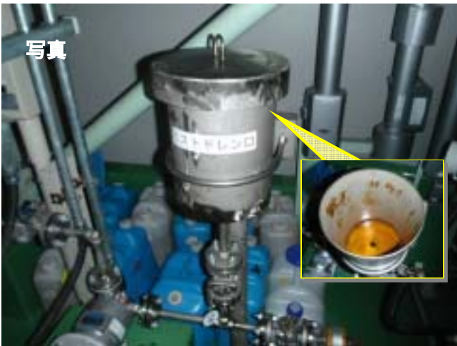
保管していた回収油を処理系へ戻した、ミストドレン口。四角内はその蓋を開けたところ。
