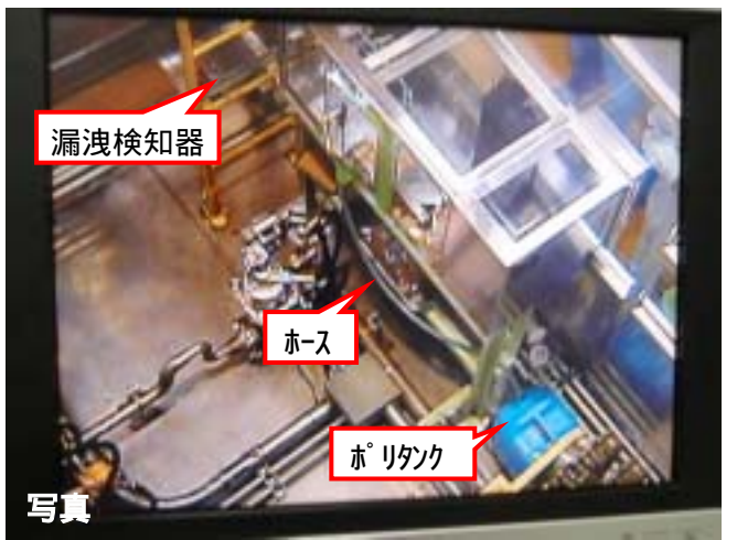
廊下に設置してあるモニターから漏洩現場を確認したところ。
