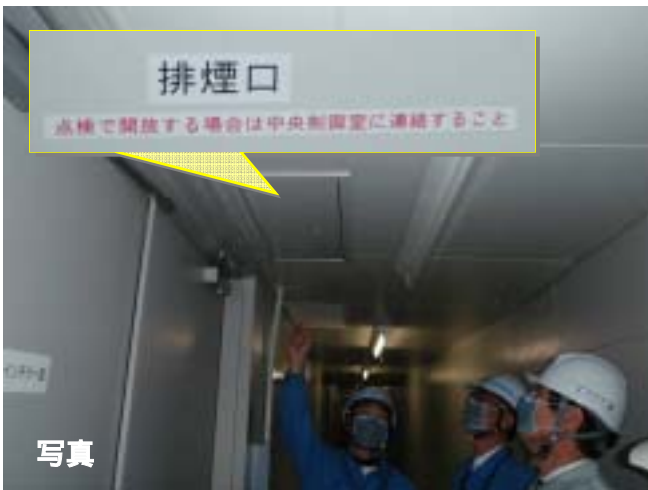
定期点検中に開けられた排煙口。開放する際、中央制御室に連絡する旨の注意書きあり。
