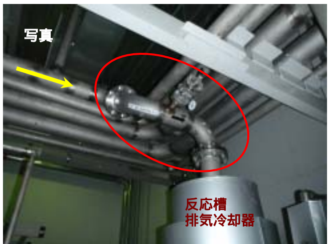
円内が事故当日切り離されていた排気管。排気は左から冷却器に送られる。
