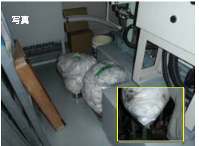
11月19日に床を拭き取ったウェス、約2.5袋分。通常の保管場所ではない窒素昇圧室に保管。
