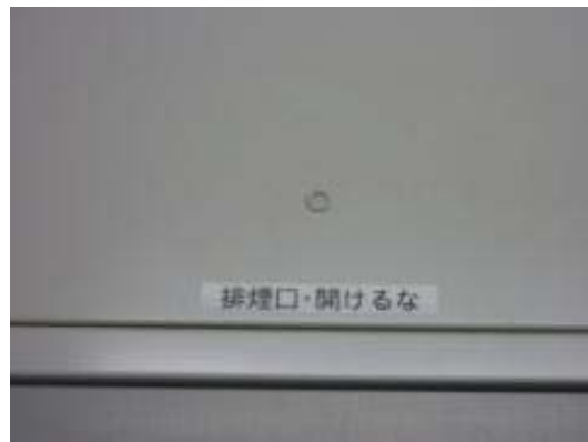
「排煙口・開けるな」の表示を追加
