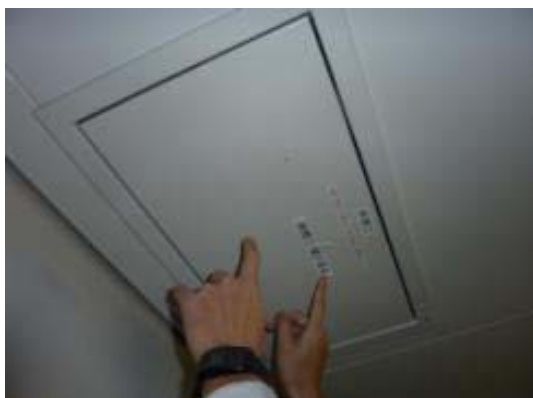
天井の非常用排煙口
