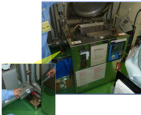
No.12 分析室 真空超音波洗浄排気 液種:洗浄液 PCB有
