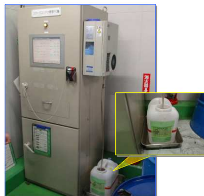
No.10 操業管理システム冷却器 液種:ドレン水 PCB無
