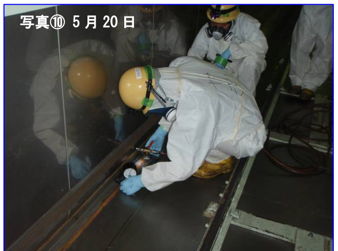
遮蔽フード内の SUS 床コーキング部のリークテストの状況を確認しました。
