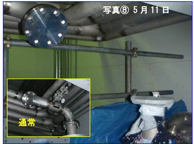
昨年11月19日の漏洩事故があった、配管の切り離し作業の状況を確認しました。
