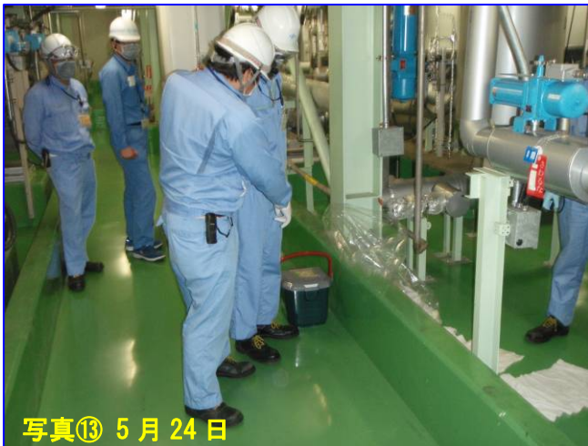
液処理班が実施した漏洩対応訓練を確認しました。
