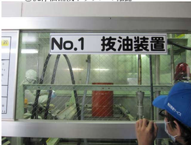
④洗浄油漏洩トラブルの確認
