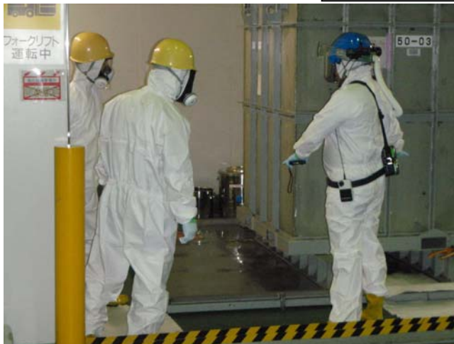
②液体漏洩訓練の確認
