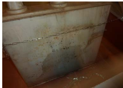
コンデンサ表面のにじみ例
