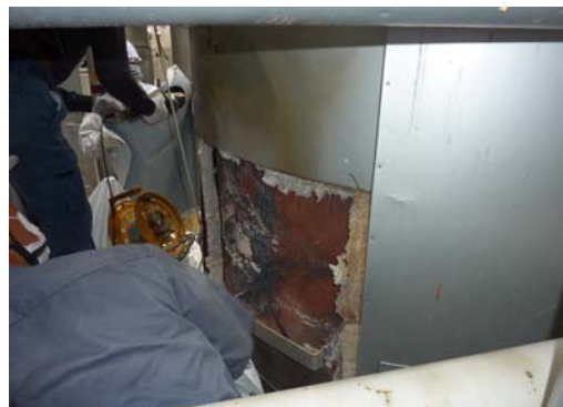
改修作業中の様子
