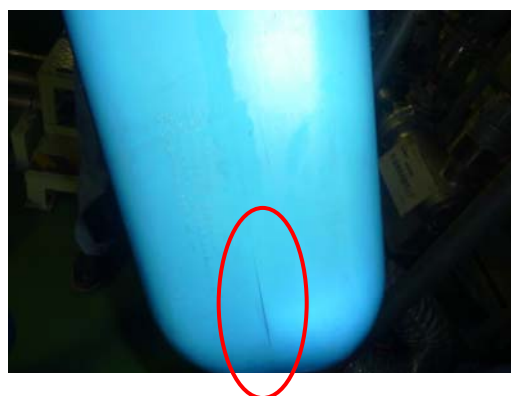
ポリタンクのひび割れ
