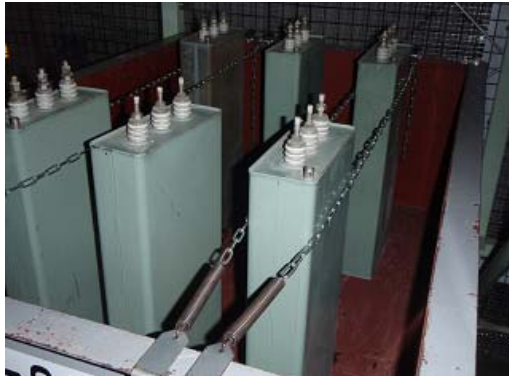
立体倉庫のトレイ内の固縛の様子
