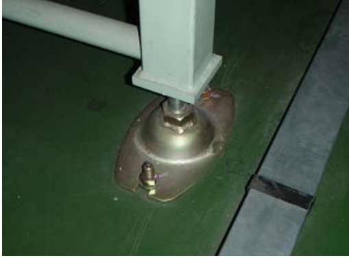
立体倉庫の脚が床に固定されている様子
