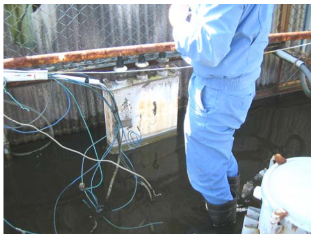
× 水没していたコンデンサ
