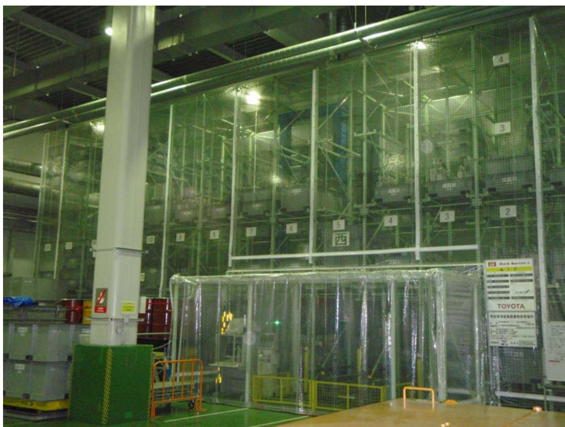
立体倉庫の写真
