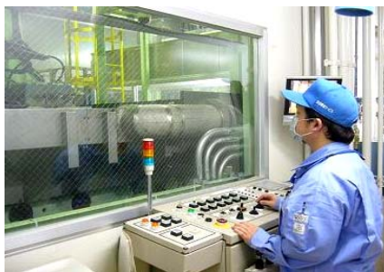
遠隔操作による小型トランスの解体作業 （遮蔽フード内作業）
