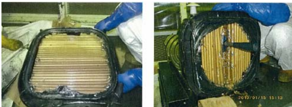
手解体の様子
