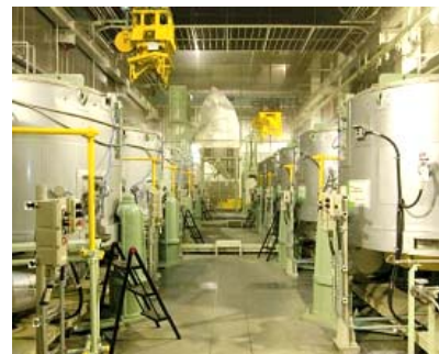
攪拌洗浄装置 （含浸物の洗浄）
