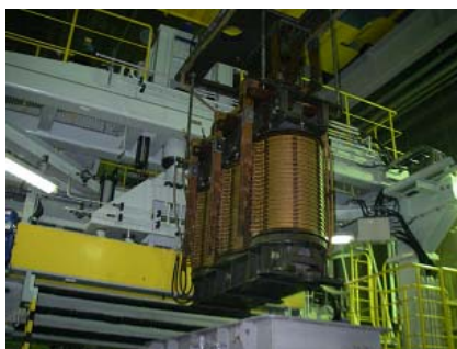
大型トランス内の鉄心・コイル取出作業
