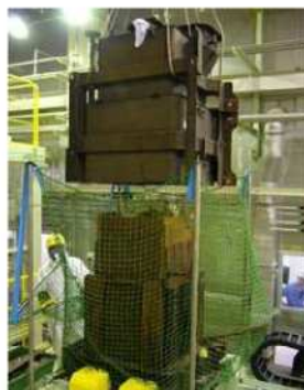
内部部材の取り出しの様子
