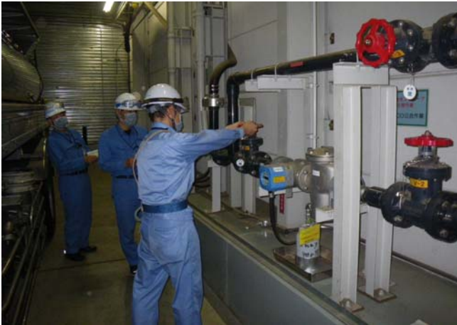
①分析廃液の払出作業の確認（7月5日立入）
