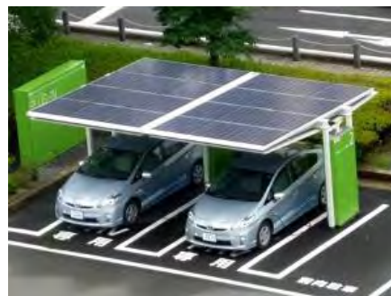
＜太陽光発電によるEV・PHV充電施設＞
