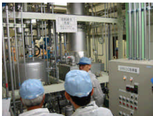
溶剤再生工程
