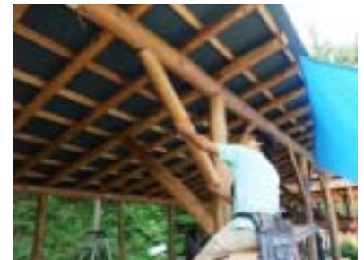
柱の補強をして、屋根は完成です。
