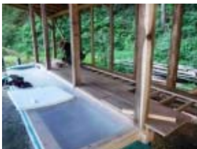
ガス貯留バッグの設置作業です
