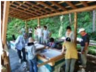
木材を加工して、ガス発酵槽に木枠を設置します
