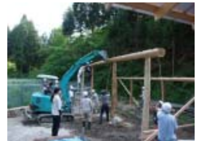
柱と梁を組み合わせます
