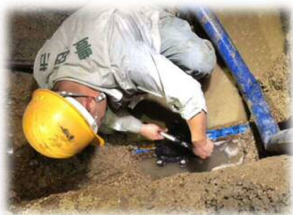
漏水修繕の様子
