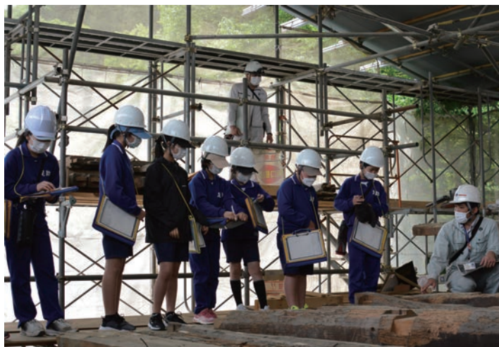
紙屋旧鈴木家住宅の修理現場を見学(令和4年5月)
