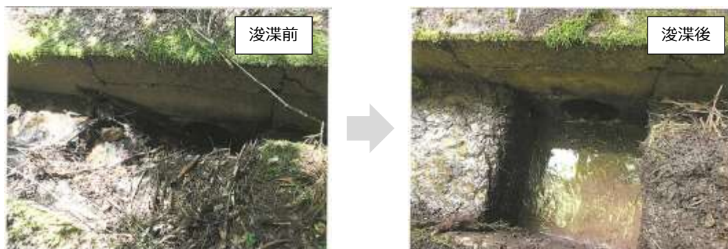
土砂等が堆積した排水施設の浚渫
