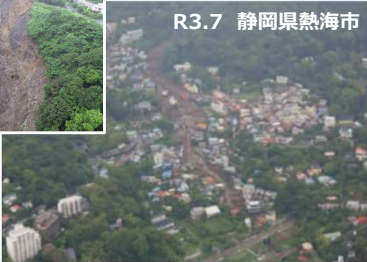
死者28名、住宅被害98棟
