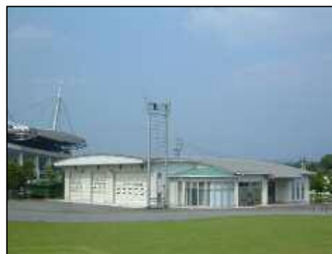
矢作川豊田防災ステーション
