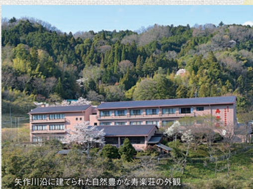
矢作川沿に建てられた自然豊かな寿楽荘の外観
