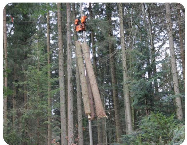
<タワーヤードによる集材>
