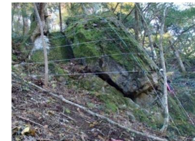
ワイヤーロープ掛工
