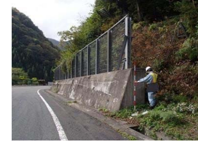
落石防護柵工
