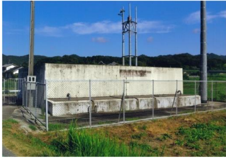
写真 X-162 矢作川利水北部幹線かご川放流工
