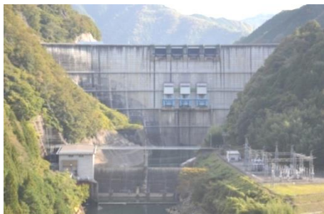
写真 X-1 矢作第一ダム
