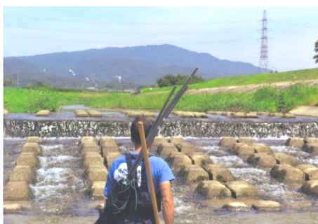
写真 X-158 籠川の整備された落差工と河床（先方の山は猿投山）
