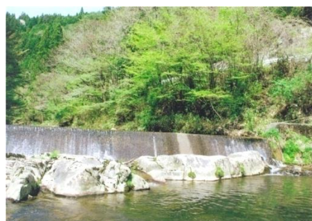
写真 X-53 段戸川の大規模な落差工
