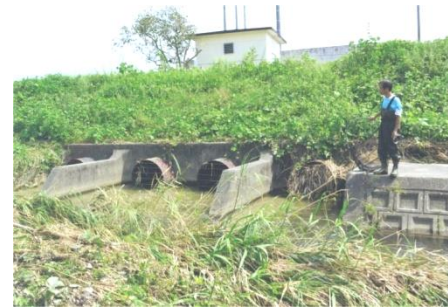
写真 X-168 北部幹線の 4 本の排水口
