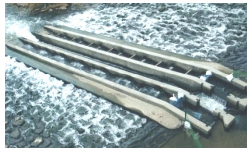
写真 X-320 魚道2本に改良された落差工
