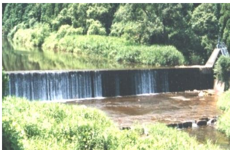
写真 X-319 魚道のない高さ1m余の落差工
