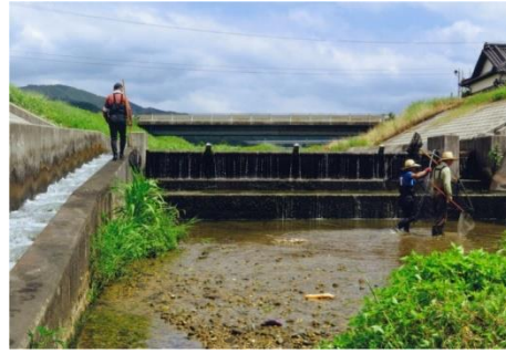
写真 X-163 魚道付きの堰堤（籠川上流域）
