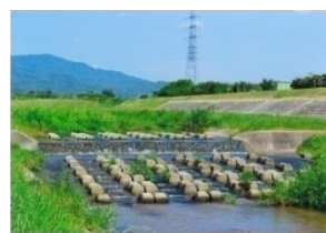
写真 X-160 アユも遡上できる 落差の小さい落差工
