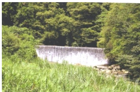
写真 X-27 魚道のない高さ数 m の落差工
