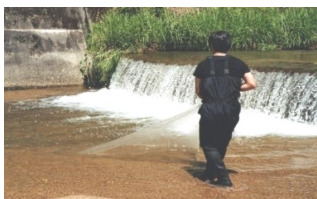
写真 X-36 犬伏川の二段式の落差工 (藤岡地区)
