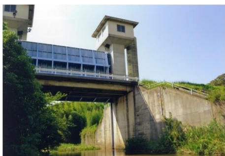
写真 X-148 加茂川水門 (この下に高さ数十 cm の落差工がある)
