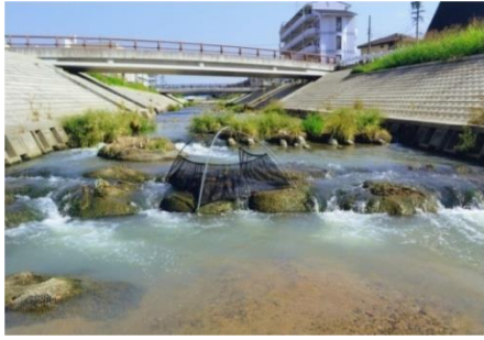
写真 X-208 逢妻男川の低い落差工 (回遊魚だけでなく一般魚も遡上する)
