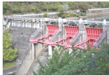
写真 X-2 矢作第二ダム
