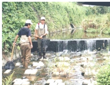
写真 X-16 落差工と護床ブロック
