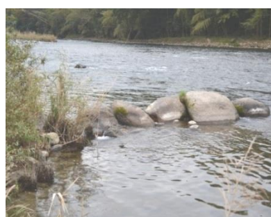
写真 X-103 合流点付近の旧築場の水制工
