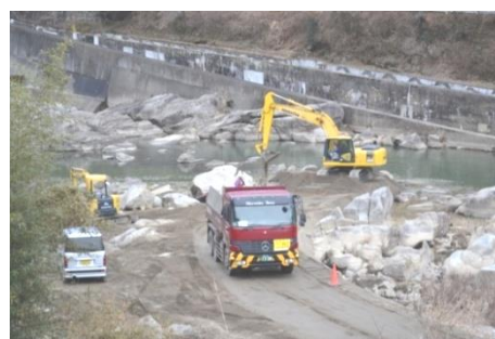
写真 X-235 仮設道路新設工事現場
