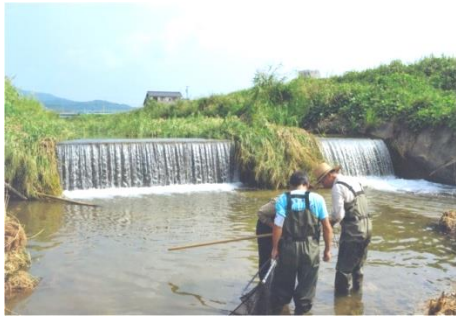
写真 X-166 高さ 2m の落差工(籠川)
