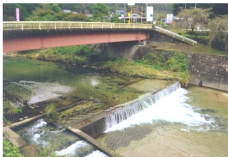
写真 X-48 川ヶ渡橋下の魚道のある落差工
