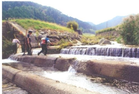
写真 X-61 小田木川の複数段の落差工
