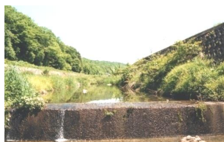
写真 X-37 魚道のない落差工 (藤岡地区)
