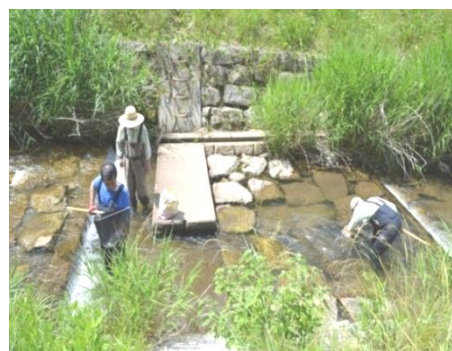
写真 X-191 仁王川の河川整備が完了区間
