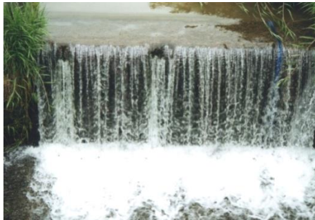
写真 X-30 大規模な千洗川の落差工
