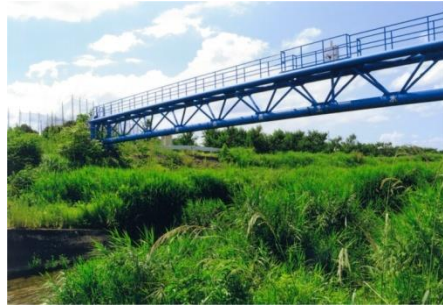
写真 X-164 籠川上流の水管橋
