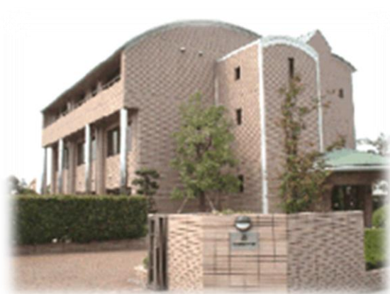
桜井本社ビル
