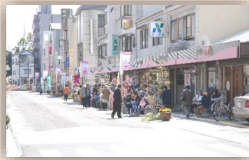
■ 道路整備の事例（市道中町線）
