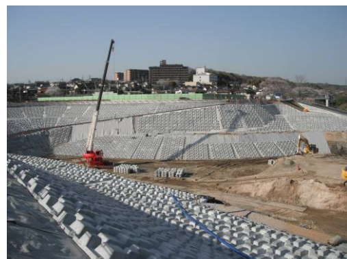
写真-3（護岸ブロック完了）
