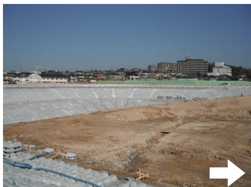
写真-2（1次掘削完了）
