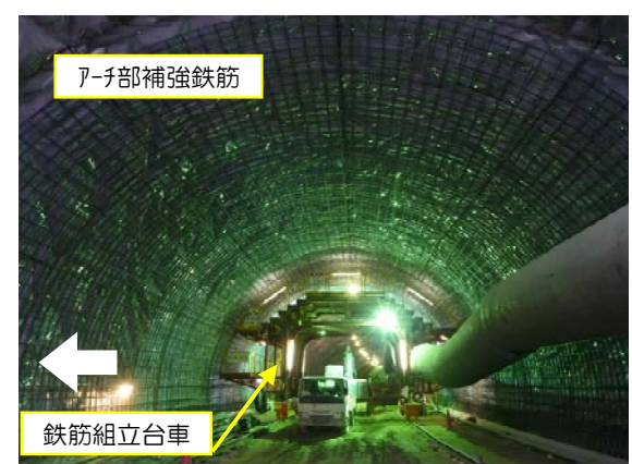
写真-5（アーチ部鉄筋組立）
