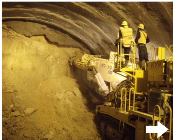
写真-1 （掘削状況・自由断面掘削機）
