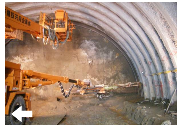
写真-3 （ロックボルト打設・油圧ホイールジャボ）
