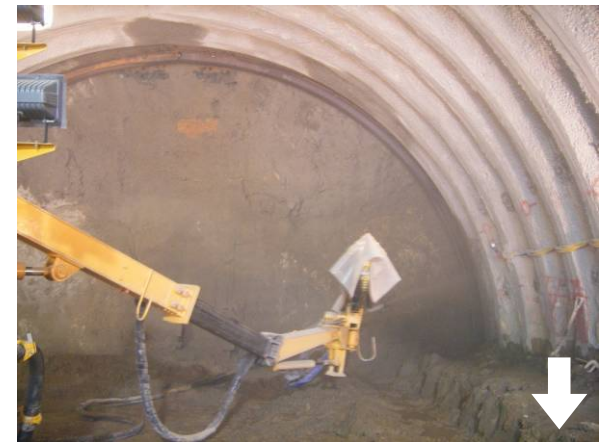
写真-2 （2次吹付・吹付機）
