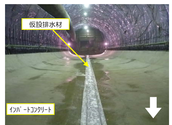
写真-4（インバートコン打設）
