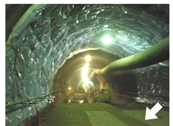
写真-2（防水シート設置）
