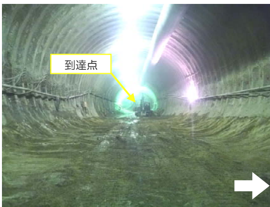
写真-1（掘削完了）
