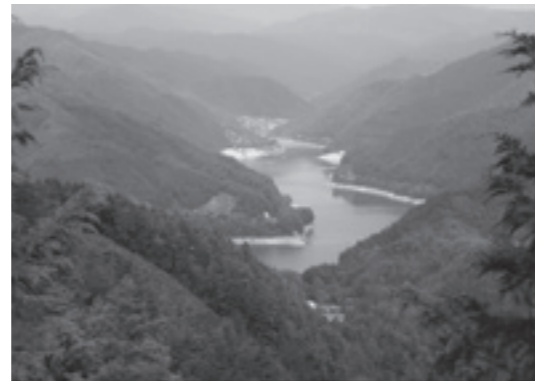
良好な水源の確保 (矢作ダム)
