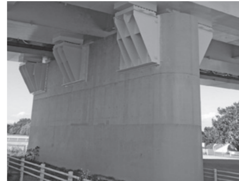
重要橋りょうの耐震補強
