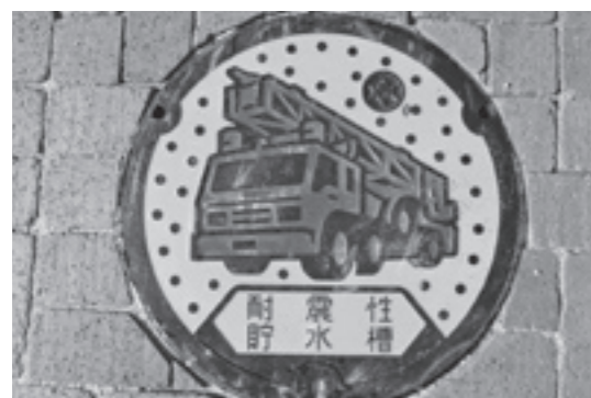
耐震性貯水槽
