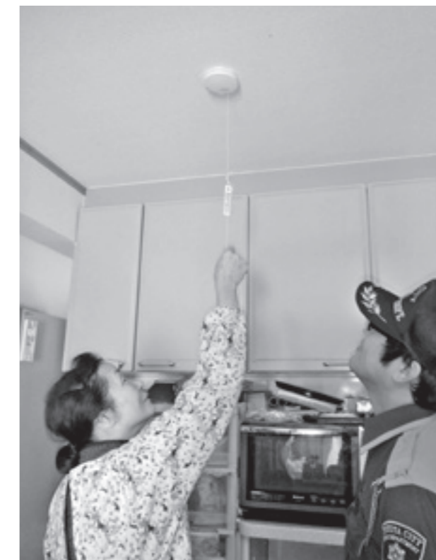
住宅用火災警報器取付確認
