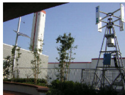
エコットの風力発電設備
