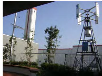
eco-Tの風力発電設備
