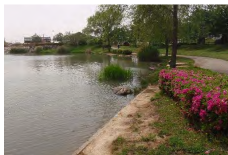
親水機能を持たせた、ため池整備
