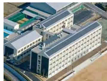
藤岡南中学校の太陽光発電
