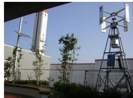
eco-Tの風力発電設備
