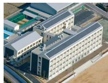
藤岡南中学校の太陽光発電
