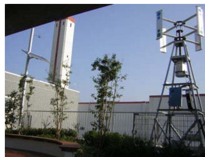
eco-T の風力発電設備
