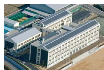
藤岡南中学校の太陽光発電
