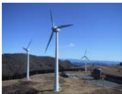
面ノ木風力発電所
