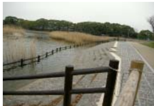
親水機能を持たせた階段護岸
