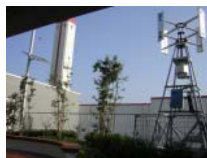
eco-T の風力発電設備
