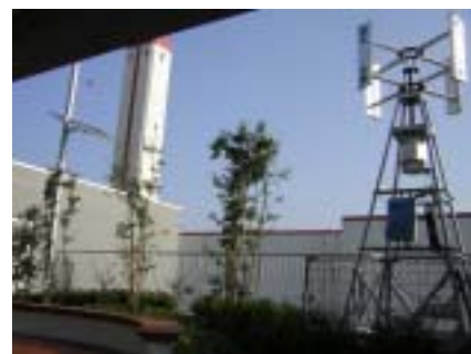
環境学習施設 eco-T(エコット)の風力発電設備
