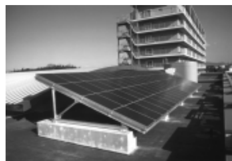
西部コミュニティセンターの太陽光発電システム
