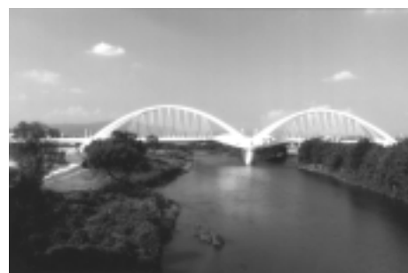
親水に配慮した豊田大橋
