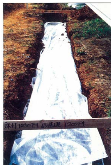
図 8-6 透水シート覆工後の状況
