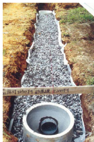
図 8-4 ます、透水管の据付
