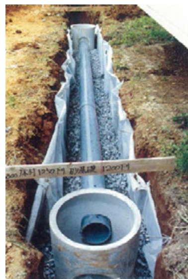
図 8-5 充填砕石工の完了
