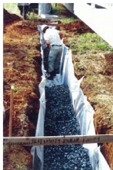
図 8-3 充填碎石の施工
