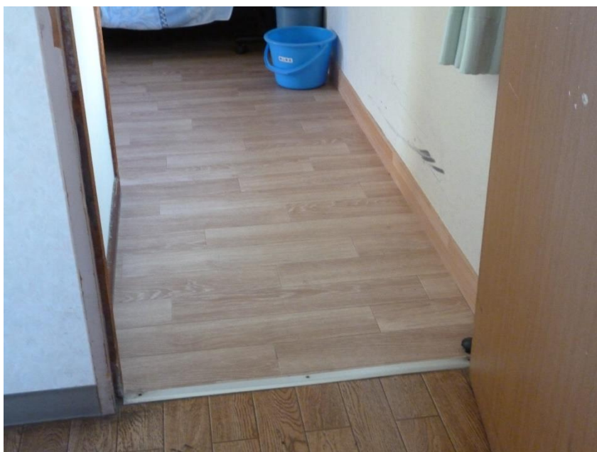
写真7 4 居室の和室床修繕②（修繕後）
