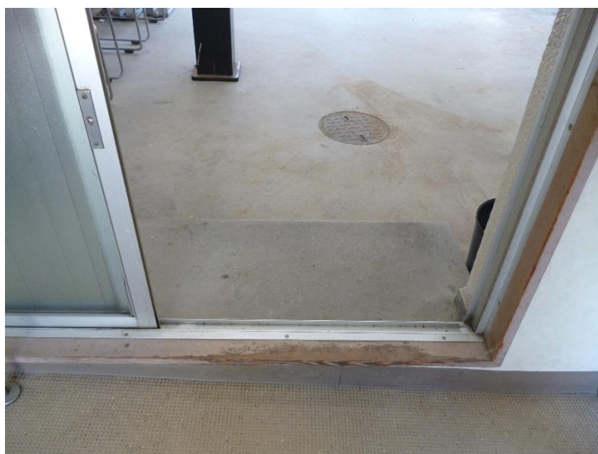
写真3 3 居室南側及び東側の整地並びに雨天干場の避難用通路の整備①
