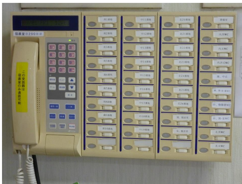
写真2 2 ナースコールの改修及びコードレス電話機の設置②
