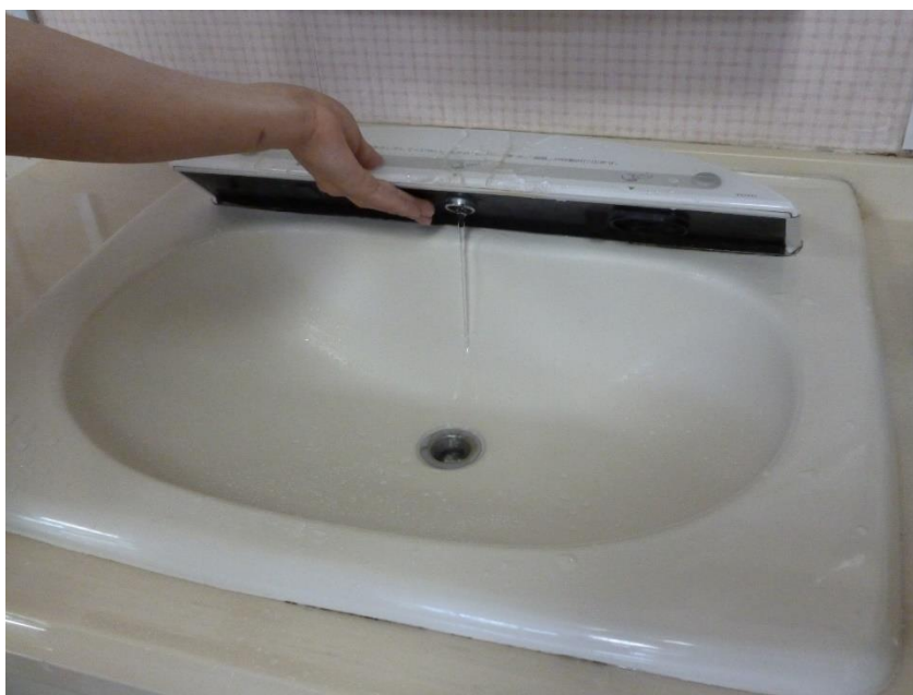
写真10 食堂の洗面台のトラブル
