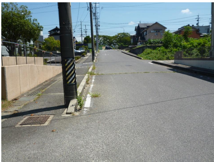
写真9 5 駐車場外灯設置②
