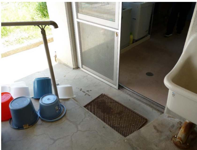
写真4 3 居室南側及び東側の整地並びに雨天干場の避難用通路の整備②
