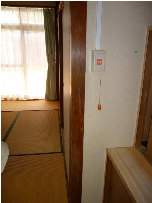
写真1 2 ナースコールの改修及びコードレス電話機の設置①
