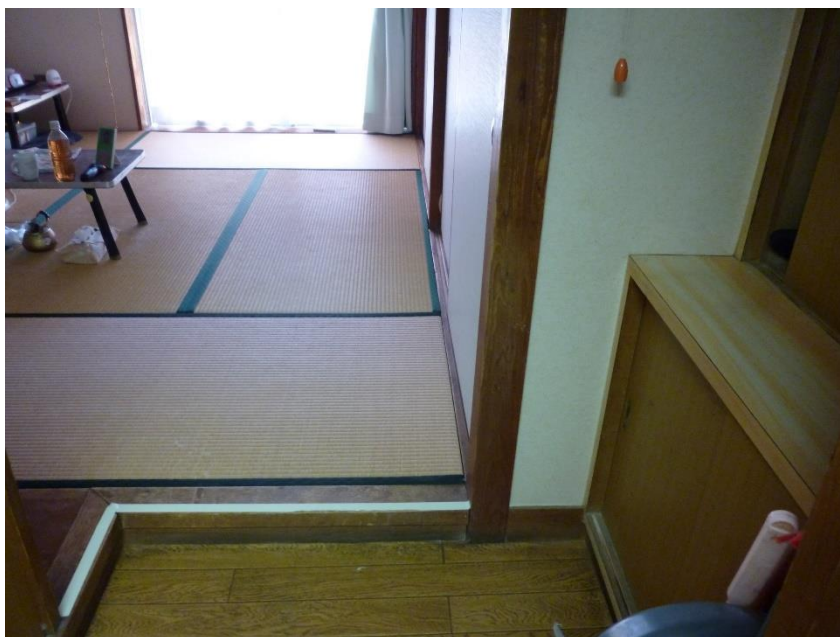
写真6 4 居室の和室床修繕①（修繕前）
