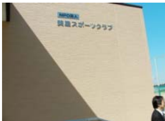
東山体育センターに隣接する美里スポーツクラブのクラブハウスの外壁
