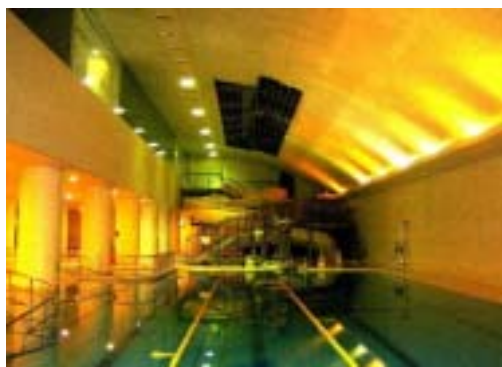
落下事故全景、上部の黒い所が落下した天井部分
