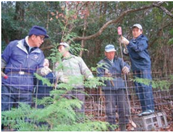
ワイヤーメッシュ柵の設置風景。総延長11kmにわたって設置作業を行いました。
