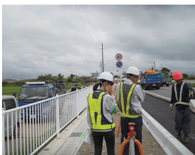
安全パトロールの様子
