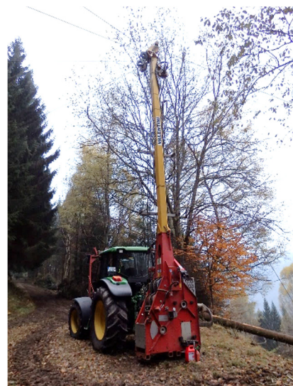
写真6 中型タワーヤードの活用（ドイツ）
