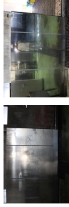
（検査告知前） （検査時）
