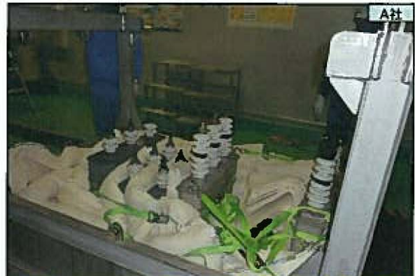
⑦各社のコンデンサ固縛、吸収材の状況
