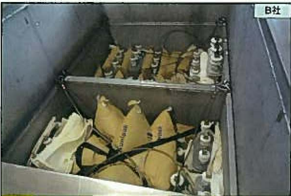
⑧各社のコンデンサ固縛、吸収材の状況
